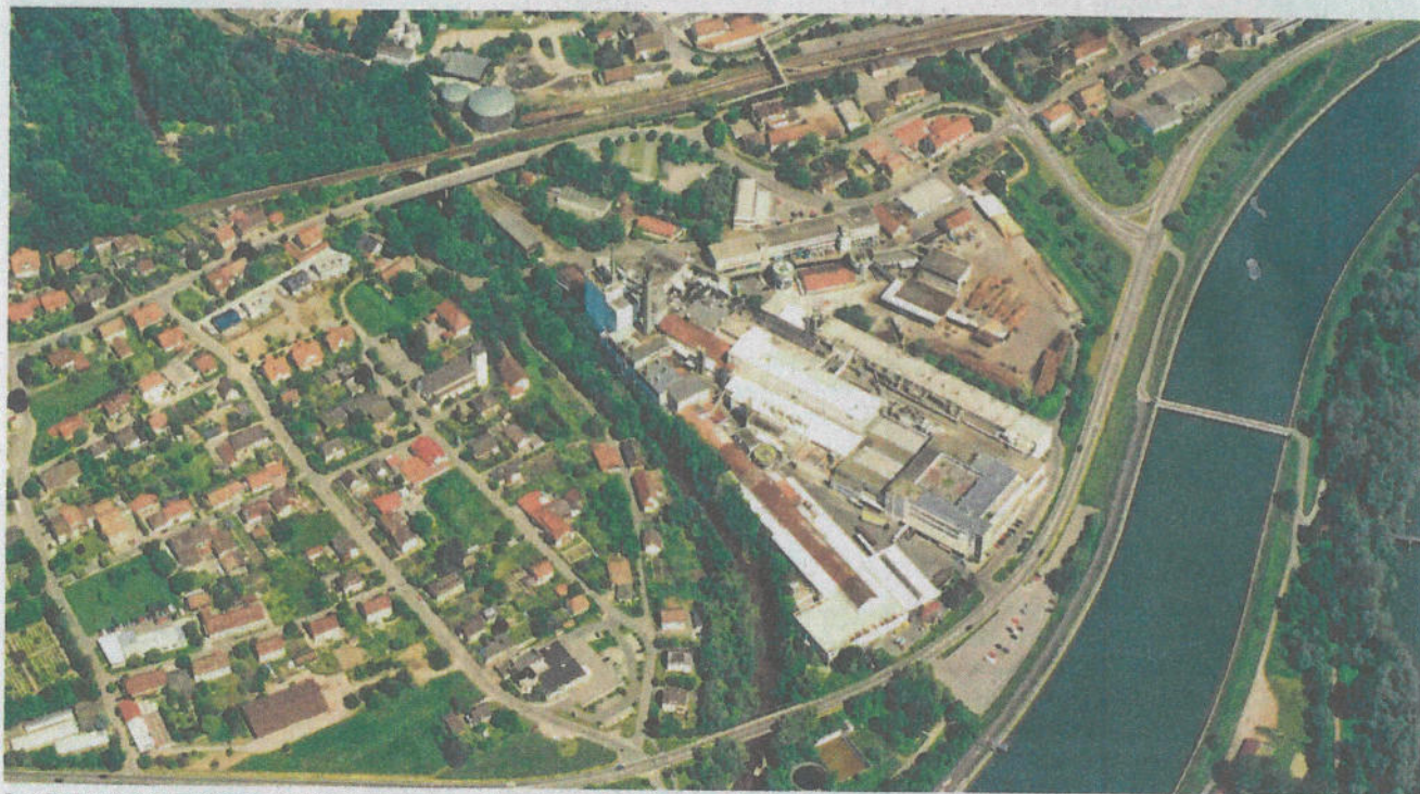
Der Bebauungsplan für das Gelände der ehemaligen Papierfabrik Albbruck (Bildmitte) ist in Vorbereitung. Vor einer neuen Nutzung mit Wohnen und Gewerbe müssen die alten Industriegebäude abgerissen werden. BILD: SPARKASSE HOCHRHEIN
