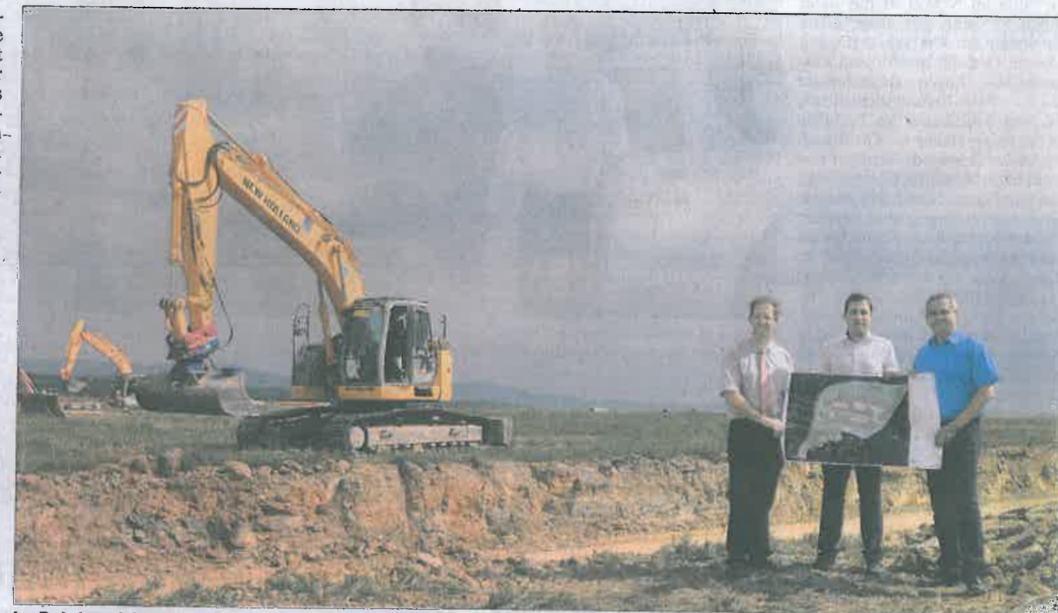
Im Rohrbergfeld 2 graben die Bagger für die Erschließung. Über das Interesse vor allem junger Familien an den Parzellen freuen sich Bürgermeister Christian Mayer (v.l.), André Karl und Stefan Gigl.
