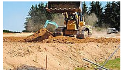
Im unteren Bereich der Fläche ist die Erde schon einen Meter höher.
