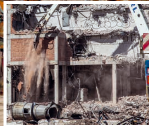
Großes Gerät: Abrissmaschinen reißen Mauern und Gebäude Stück für Stück ein.
