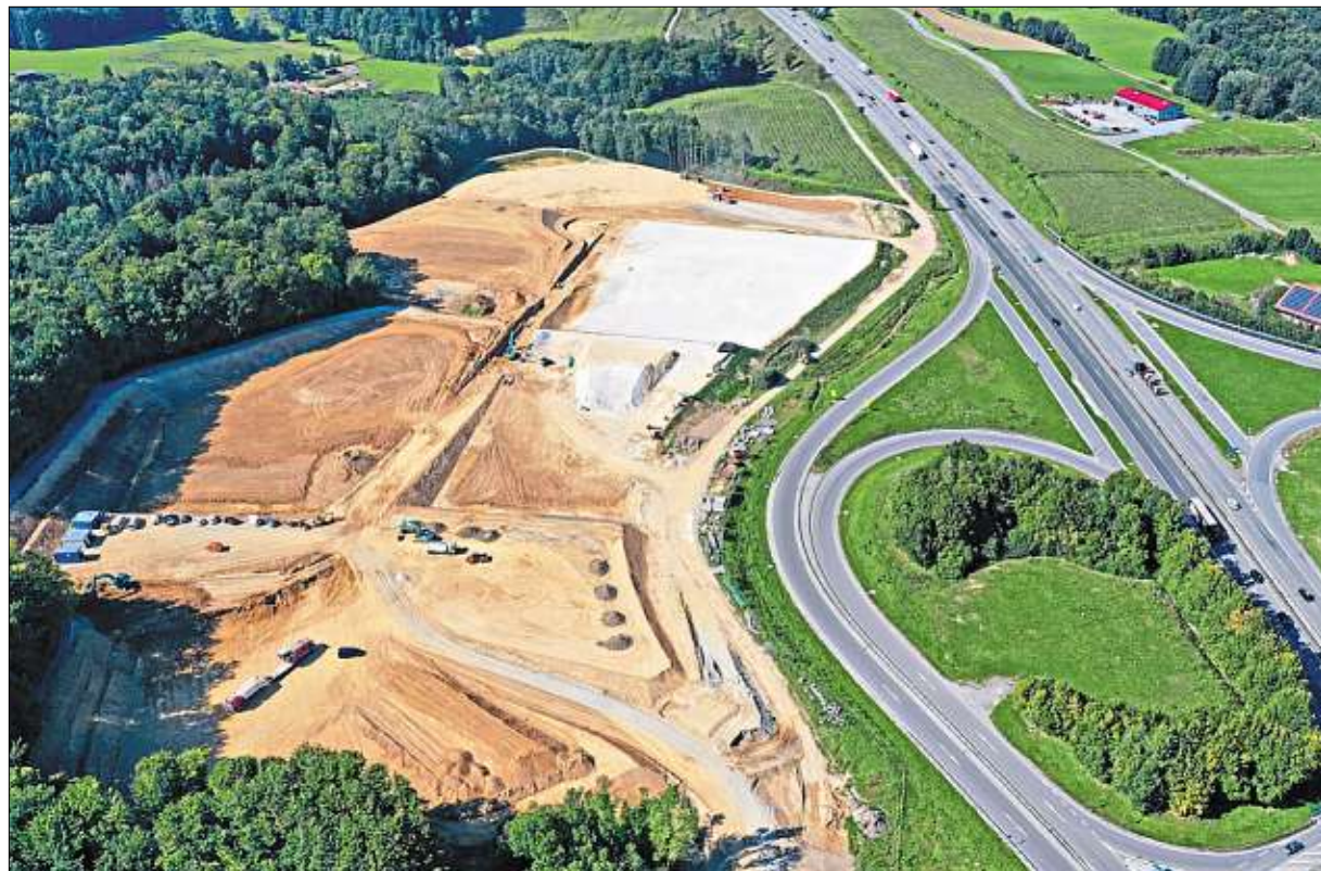
An der A-3-Anschlussstelle Iggenbach entsteht ein Gewerbegebiet. Die Baufirma Pfaffinger baut dort auf 17 800 qm einen neuen Standort für ihre Sparte Anlagenbau. – Foto: privat
