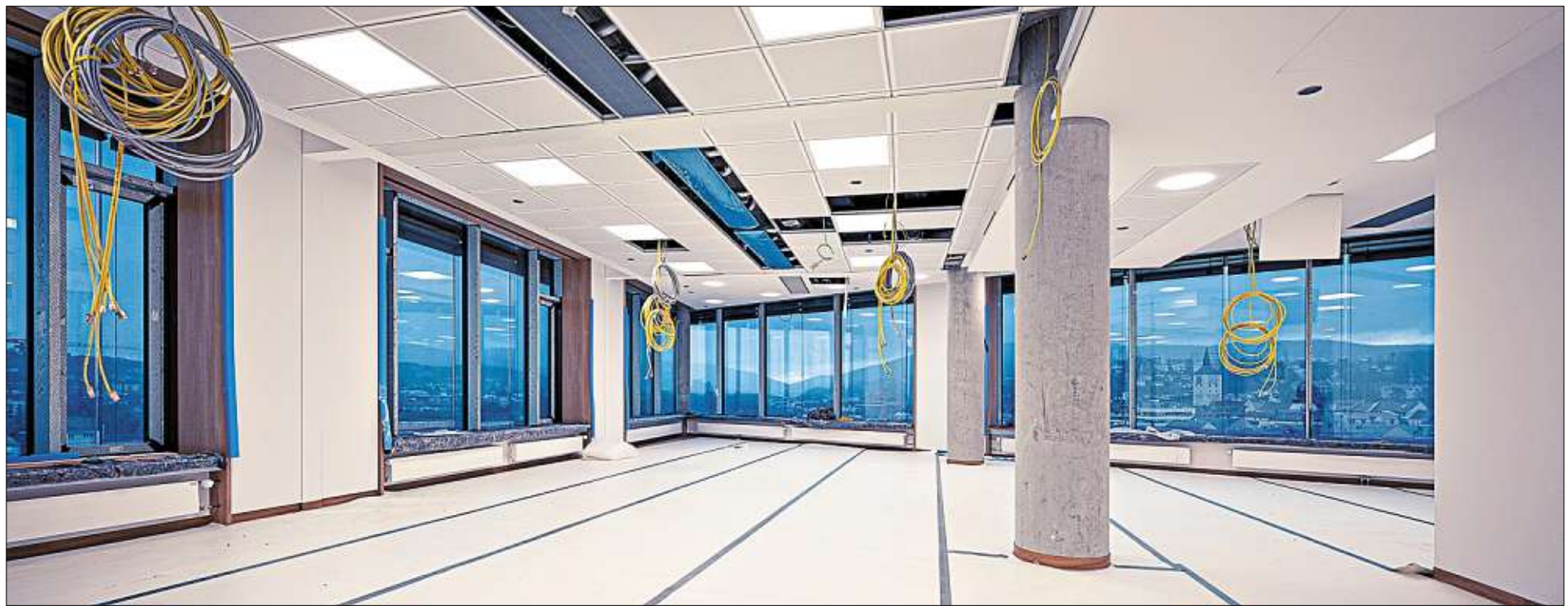
Arbeiten mit Ausblick: Fast fertig ausgebaut ist dieses Großraumbüro, das im 6. Stock und damit über den Dächern der Innenstadt liegt. – Fotos: Sebastian Kraus
