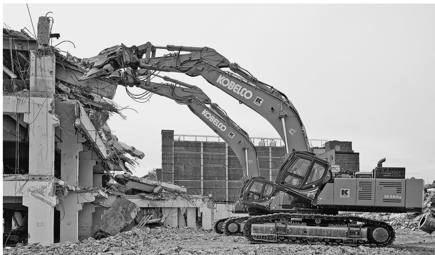
Konzertierte Aktion: Die beiden Kobelco SK850LC beim Doppelangriff in bis zu 15 m Bauwerkshöhe.
